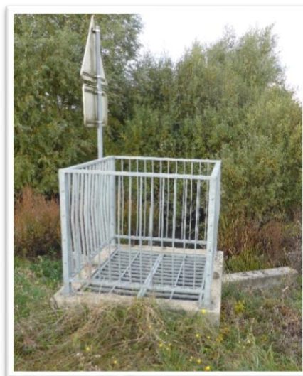
Tour de déversement, bassin « Avenue de Visitation » à Chevigny-Saint-Sauveur
