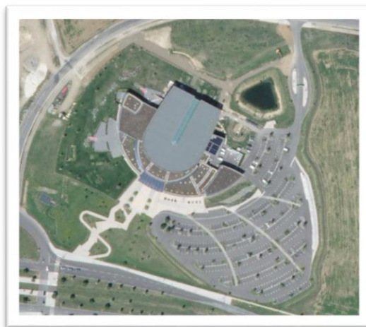
Piscine Olympique de Dijon-Métropole à Dijon
