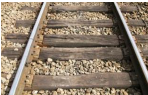
Rails courts sur traverses bois
